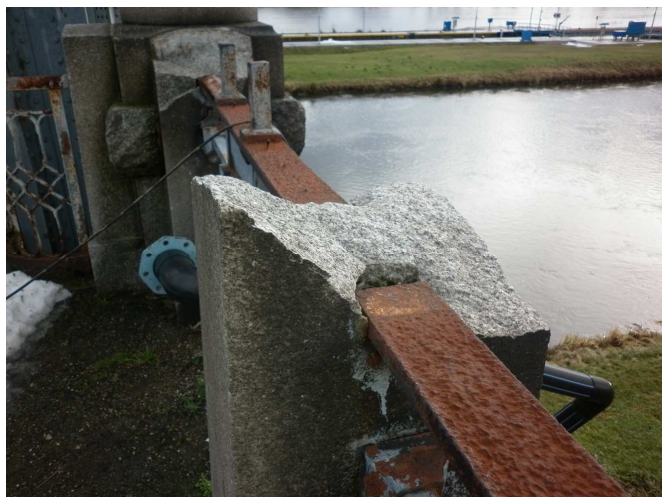
Obr. 5.11 – dnešní stav poškozeného zábradlí
