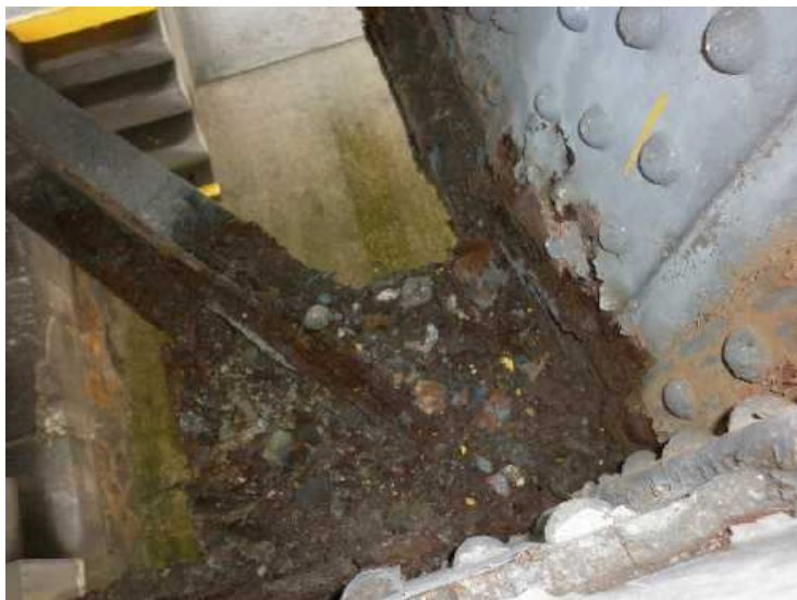
Obr. 2.27 - NK - pole 2, detail koroze styčnickového plechu.
