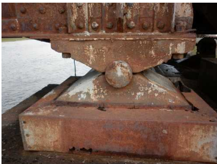
Obr. 2.45 - NK - pole 4, ložisko na pilíři P5, povrchová koroze.
