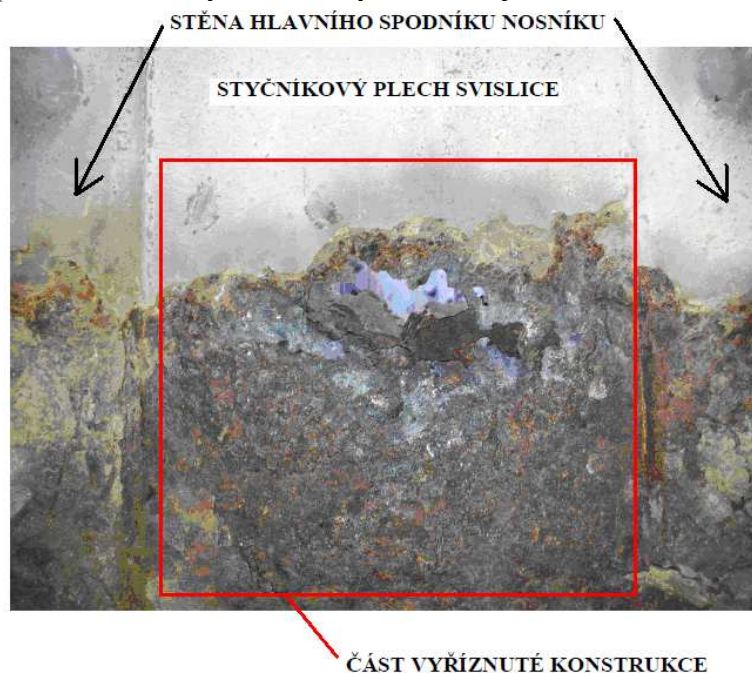
Obr.5.8 – schématické znázornění náhrady zkorodované části svislice vyříznutím a nahrazením novým plechem
