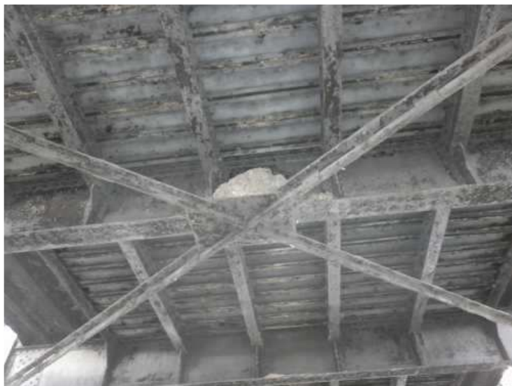
Obr. 2.29 - NK - pole 2, na styčnickovém plechu dolního ztužení jsou zbytky betonu.
