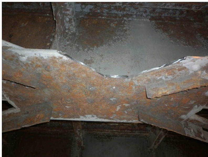
Obr. 3.2 – Dolní styčník nosné konstrukce v poli 5, kde byl odebrán vzorek S1.
