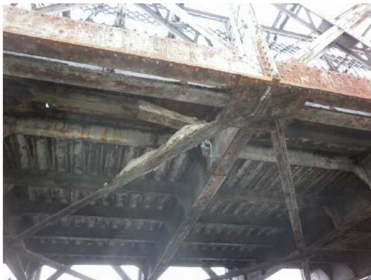
Obr. 2.26 - NK - pole 2, silná koroze styčnickového plechu, na diagonále dolního ztužení zbytky betonu. Betonový podélník podporující kolejnici je zcela rozpadlý.
