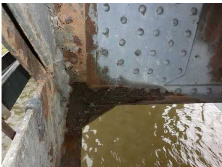
Obr. 2.48 - NK - pole 5, návodní strana, detail koroze ve styčnickovém plechu dolního hlavního nosníku a příčnicku.
