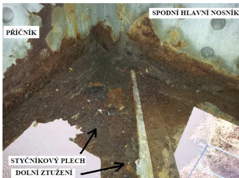
Obr. 5.2 – typické místo poškození nosné konstrukce korozí – styk dolního ztužení a spodního hlavního nosníku
