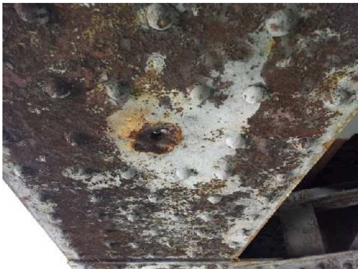
Obr. 2.38 - NK - pole 3, návodní strana, koroze spodního líce hlavního nosníku v místě 15 příhrady.
