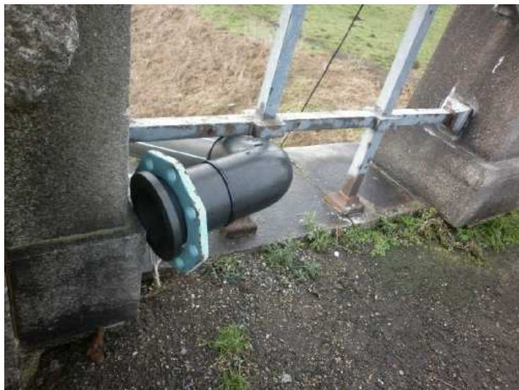
Obr. 2.53 - Předmostí před OP1, návodní strana, plastová chránička je ukončena pod zábradlím.
