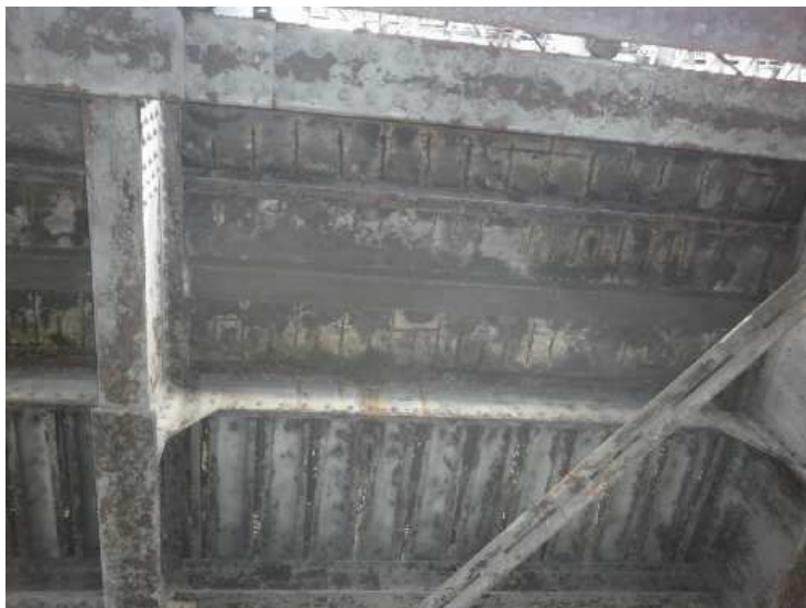
Obr. 2.23 - NK - pole 1, nedostatečná tloušťka krycí vrstvy betonové desky, plošná koroze betonářské výztuže.
