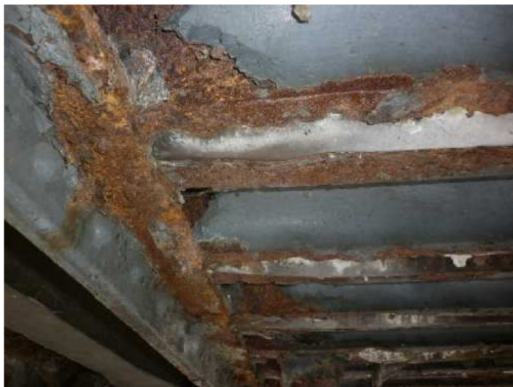
Obr. 2.23 - NK - pole 1, detail napojení ocelových profilů mostovky Zores na krajní podélník, silná koroze.
