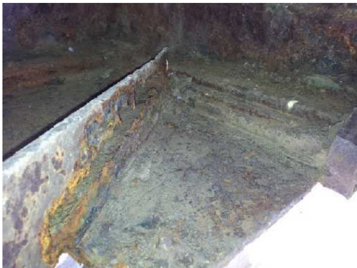
Obr. 2.44 - NK - pole 4, povodní strana, koroze zcela přerušeny profil dolního ztužení v místě napojení na styčnickový plech 3 příhrady.
