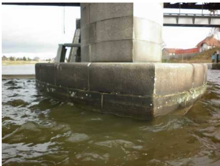
Obr. 2.15 - Vyplavené spárování v úrovni kolísání hladiny Vltavy v patě pilíře P5.
