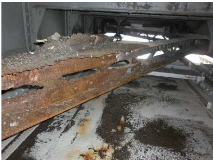
Obr. 2.36 - NK - pole 3, povodní strana, silná koroze dolního ztužení nad systémem provizorního hrazení.
