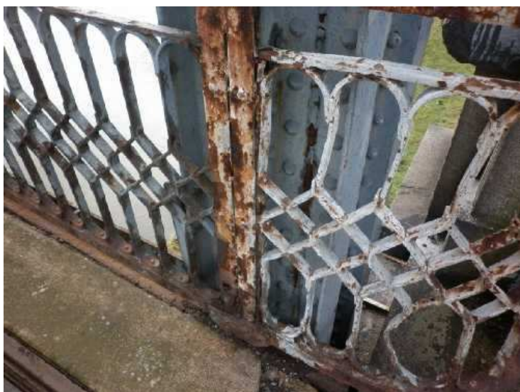
Obr. 2.57 - Zábradlí je poškozené nárazem, zábradlí plošně koroduje.
