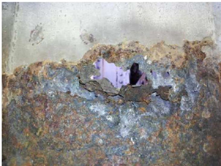
Obr. 2.40 - NK - pole 3, povodní strana, koroze zcela přerušená stěna svislice 22 příhrady.
