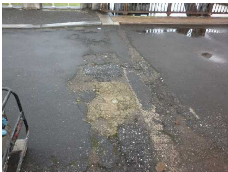
Obr. 2.54 - Pohled na vozovku nad mostním závěrem nad OP1. Vozovka se rozpadá.
