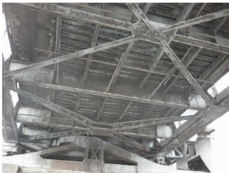
Obr. 2.43 - NK - pole 4, pohled na spodní líc NK a mechanismus kotvení NK na pilíři P4.
