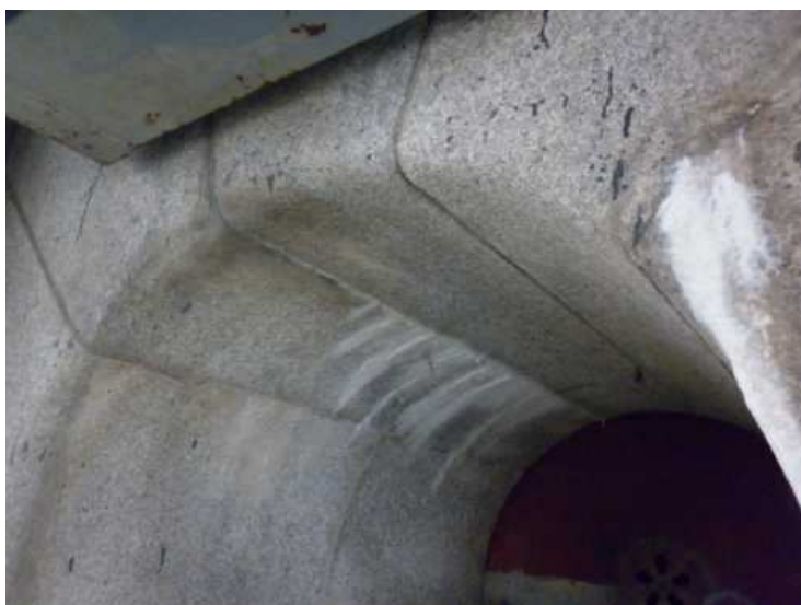
Obr. 2.17 - V místě klenutí vstupního otvoru do vnitřního prostoru krabicové opěry OP6 jsou ve spárách ve zdivu silné výluhy pojiva.
