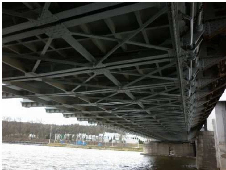
Obr. 2.7 - Spodní líc pole 3 - systém provizorního hrazení.
