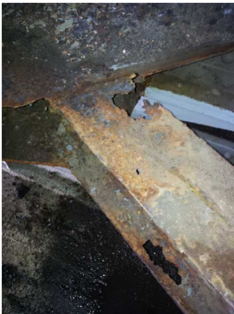
Obr. 2.37 - NK - pole 3, povodní strana, silná koroze dolní ztužení v místě napojení na styčnickový plech 9 příhrady.
