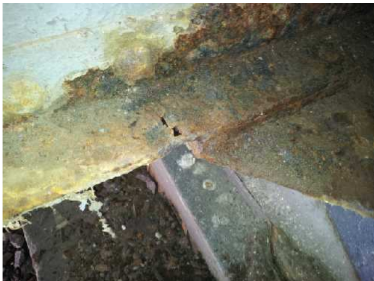
Obr. 2.22 - NK - pole 1, povodní strana, detail silné koroze dolní pásnice příčníku.
