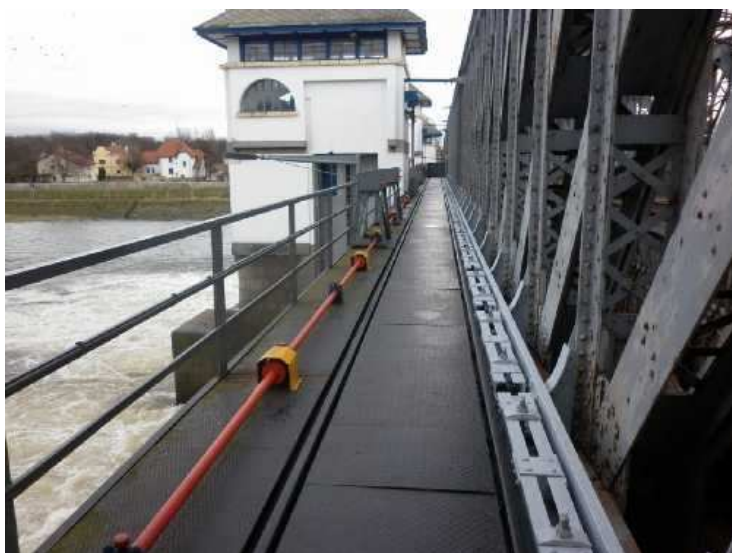
Obr. 2.51 - Pole 3 - povodní strana, konzola pojížděná mechanismem na vytahování provizorního hrazení.
