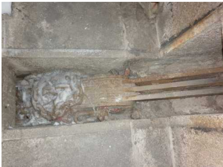
Obr. 2.13 - Detail kotvení nosné konstrukce do pilíře P3.
