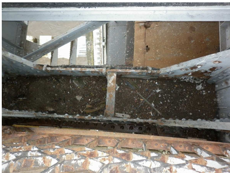
Obr. 5.5 – spodní hlavní nosník v poli 3 vyplněný nečistotami
