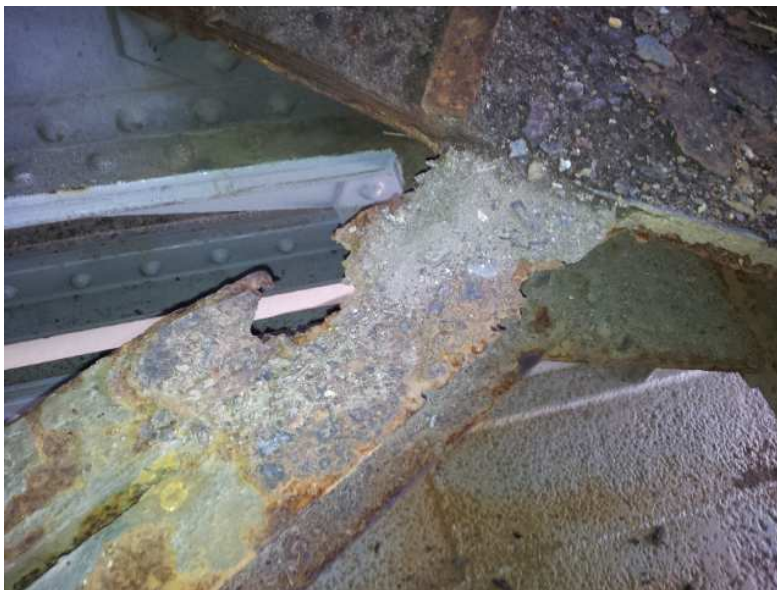
Obr. 5.9 – ukázka prutu dolního ztužení, u něhož je nezbytná celková výměna
