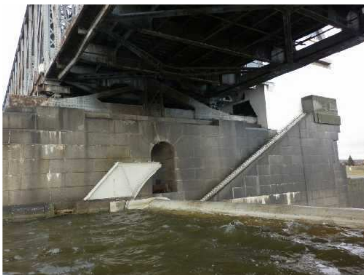
Obr. 2.14 - Pohled na líc pilíře P4 z pole 4. Na úložném prahu je patrný mechanismus kotvení nosné konstrukce do pilíře. Pod mostem jezový objekt.
