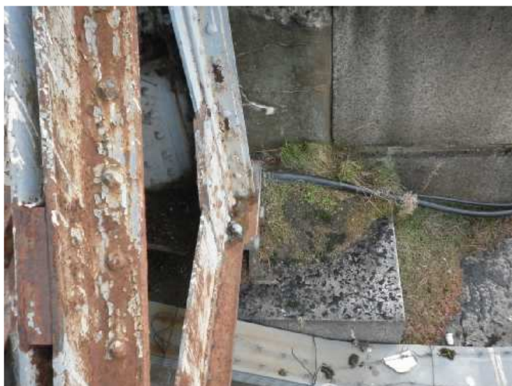
Obr. 2.18 - Na úložném prahu opěry OP6 jsou uchyceny nečistoty a vegetace, ložiska povrchově korodují. Na úložném prahu vede kabel neznámého původu.
