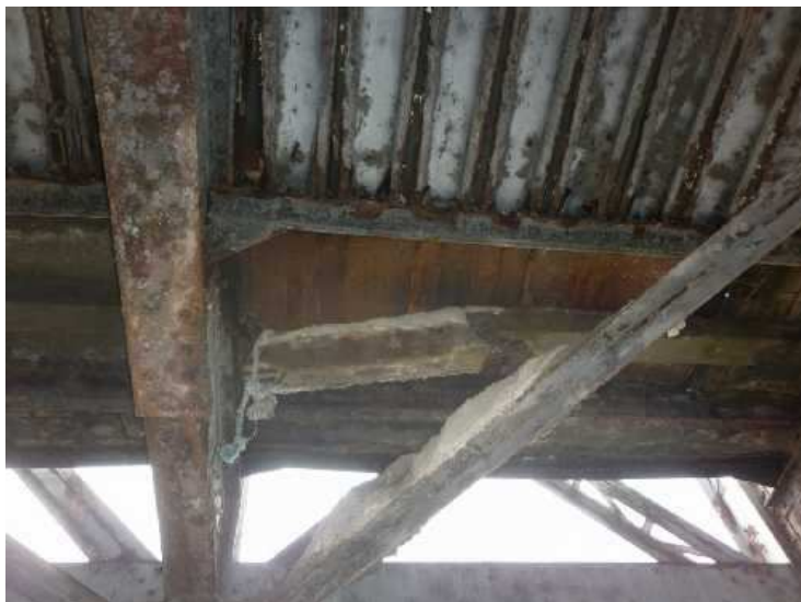
Obr. 2.31 - NK - pole 2, návodní strana, betonový podélný trám je zcela přerušen, rozpadá se.
