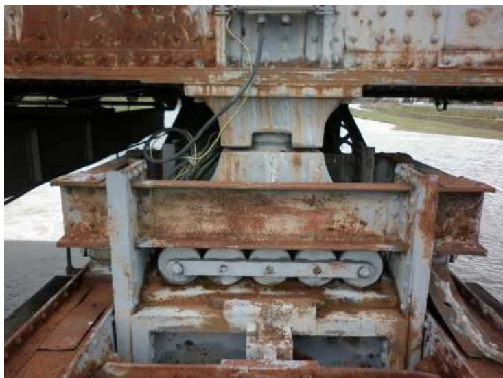
Obr. 2.41 - NK - pole 3, ložisko na pilíři P4, povrchová koroze, v okolí ložiska množství kabelů.
