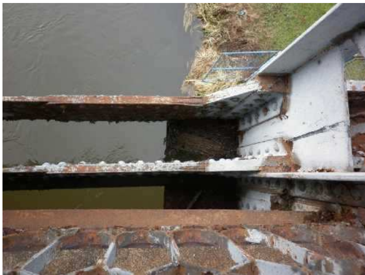
Obr. 2.19 - NK - pole 1, návodní strana, detail koroze dolního hlavního nosníku.
