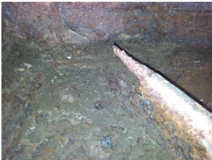
Obr. 2.28 - NK - pole 2, povodní strana, diagonála dolního ztužení je v místě 3 příhrady v napojení na styčnickový plech zcela přerušena.
