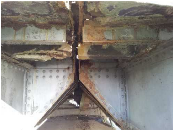
Obr. 2.24 - NK - pole 1,2, detail ukončení nosných konstrukcí nad pilířem P2, silné zatékání, hloubková degradace betonu, koroze ocelových profilů.
