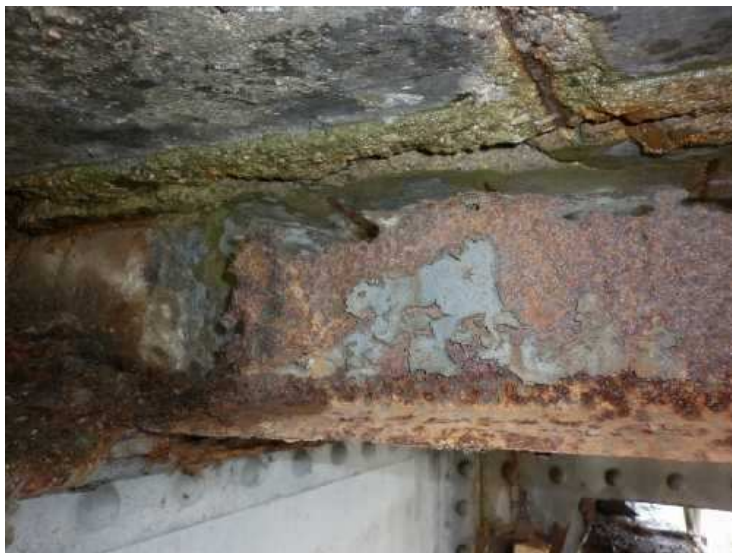
Obr. 2.20 - NK - pole 1, koroze zcela přerušovaný podélný profil pod kolejnicí na pravé straně mostovky v místě nad opěrou OP1.
