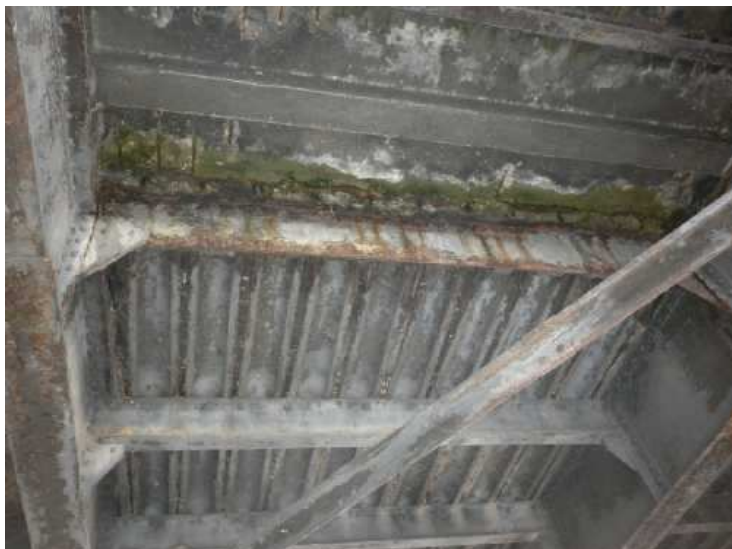
Obr. 2.33 - NK - pole 2, silné zatékání na krajní podélník a betonovou desku chodníkové části mostovky.
