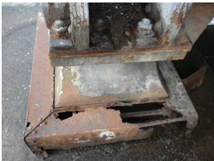
Obr. 2.46 - NK - pole 5, ložisko na pilíři P5, ochranný plechový kryt ložiska koroze rozložen, ložisko silně koroduje.
