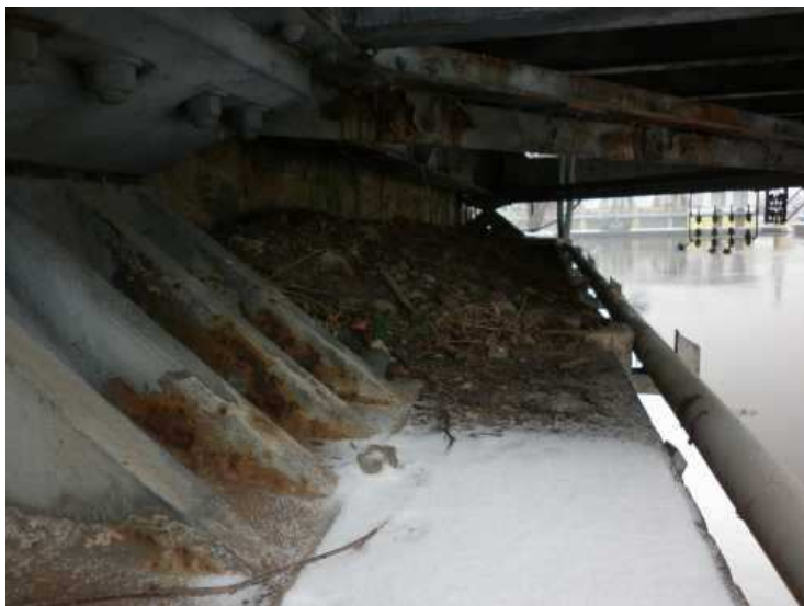
Obr. 2.11 - Nečistoty na úložném prahu opěry OP1, povrchová koroze ložisek.
