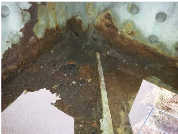
Obr. 2.21 - NK – pole 1, návodní strana, detail silné koroze styčnickového plechu třetí příhrady.
