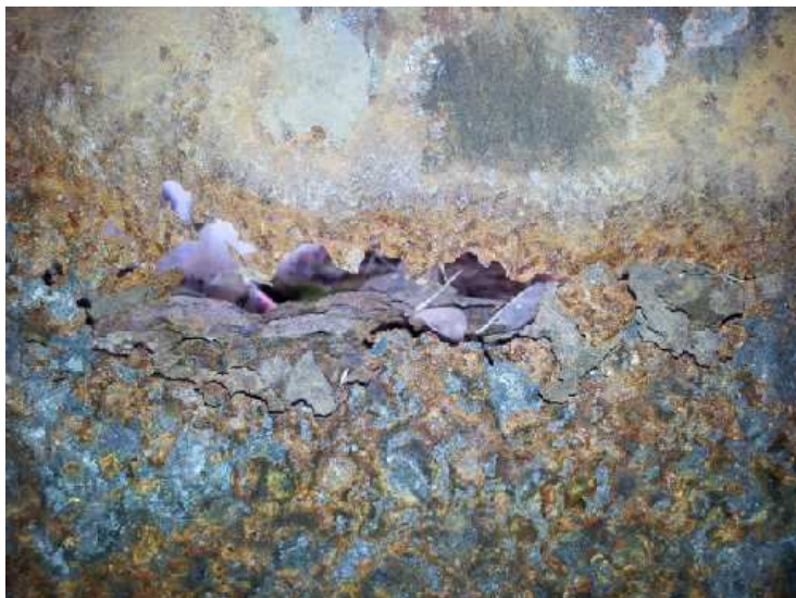
Obr. 2.39 - NK - pole 3, návodní strana, koroze zcela přerušená stěna svislice 19 příhrady.
