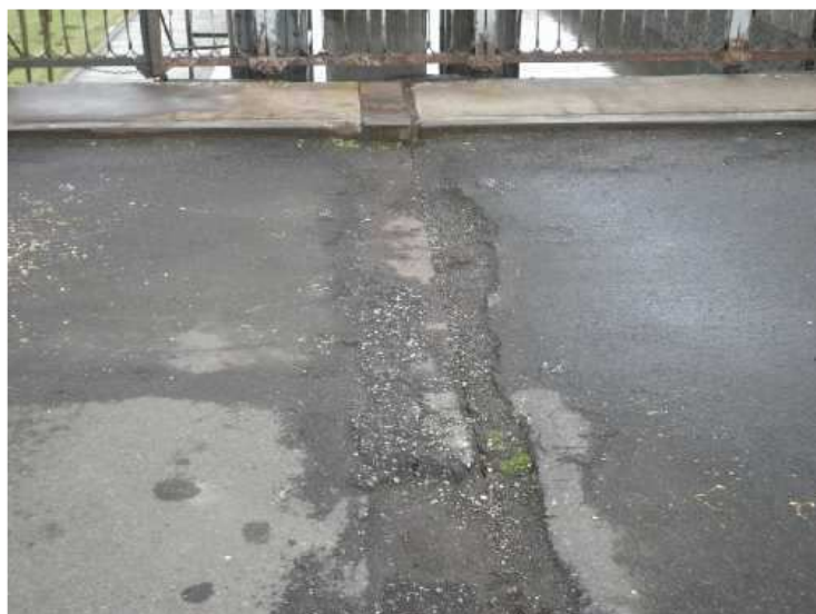
Obr. 2.55 - Detail vozovky nad mostním závěrem nad pilířem P2, vozovka je rozpadlá.
