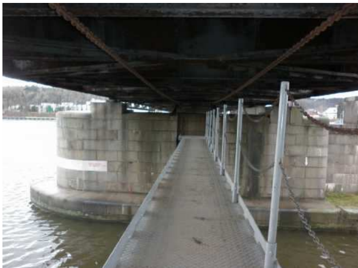
Obr. 2.47 - Pole 5 - revizní lávka pod NK pole 5.
