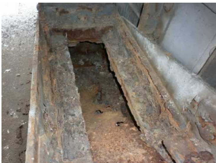
Obr. 2.34 - NK - pole 3, silná koroze kotevního mechanismu nosné konstrukce na pilíři P3.
