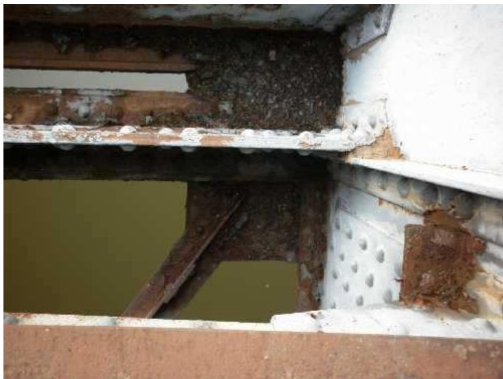
Obr. 2.30 - NK - pole 2, návodní strana, nečistoty v místě styčnickového plechu dolního hlavního nosníku, koroze.
