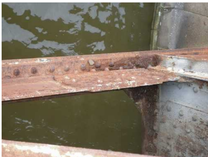
Obr. 2.49 - NK - pole 5, návodní strana, silná koroze dolního hlavního nosníku v L/2.
