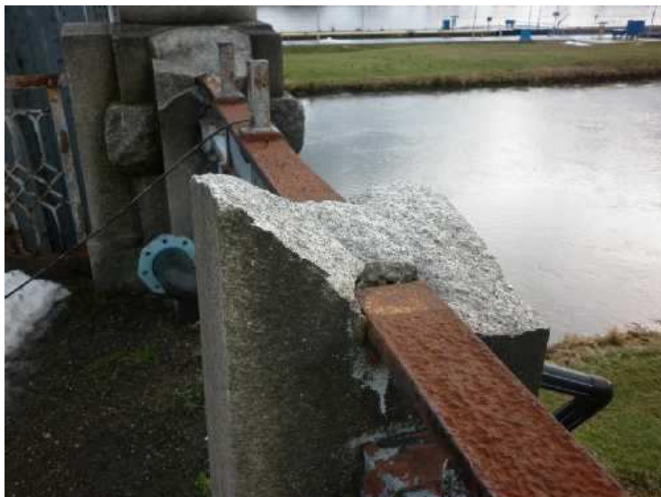
Obr. 2.50 - Předmostí na OP1, návodní strana, uražená hlava žulového sloupku zábradlí.
