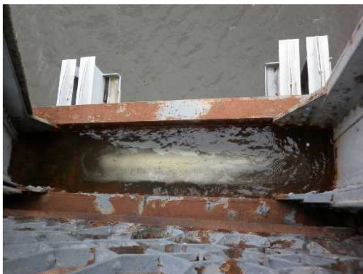
Obr. 2.35 - NK - pole 3, vodou vyplněný dolní hlavní nosník.
