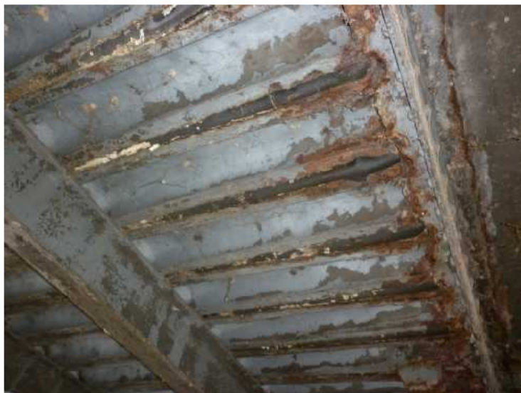
Obr. 2.32 - NK - pole 2, silná koroze na koncích ocelových profilů mostovky Zorés.
