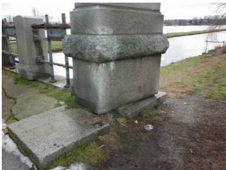
Obr. 2.52 - Předmostí před OP1, návodní strana, návodní žulový blok je celý pootočen.
