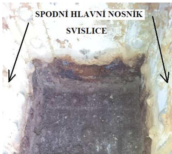
Obr. 5.3 – typické místo poškození nosné konstrukce korozí – styk svislice a dolního hlavního nosníku
