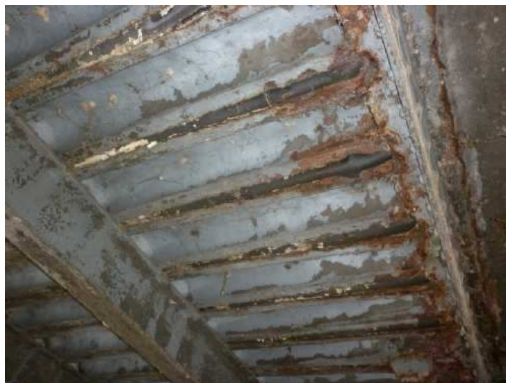
Obr. 5.4 – spodní líc mostnic Zorés vynášejících mostovku – pod vnitřními podélníky relativně dobrý stav, v místě uložení na krajní podélníky silná koroze, deformace
